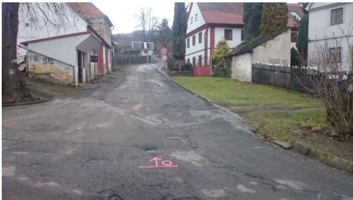
Začátek úseku oprav MK v Hlinné
