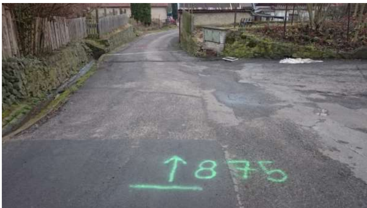
Konec úseku oprav MK v Hlinné
